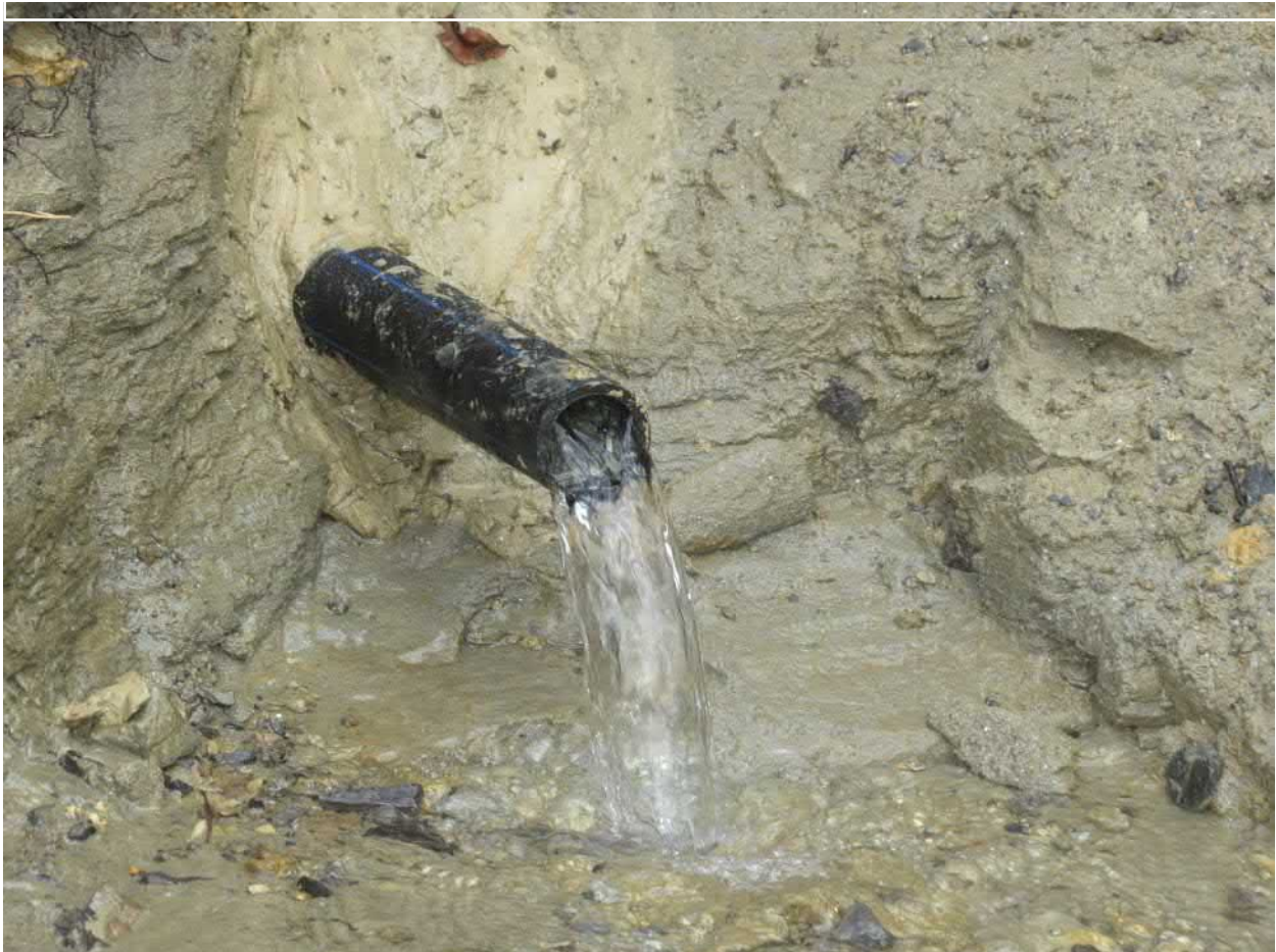
Das Wasser fließt reichlich aus der neu erstellten Horizontalbohrung
