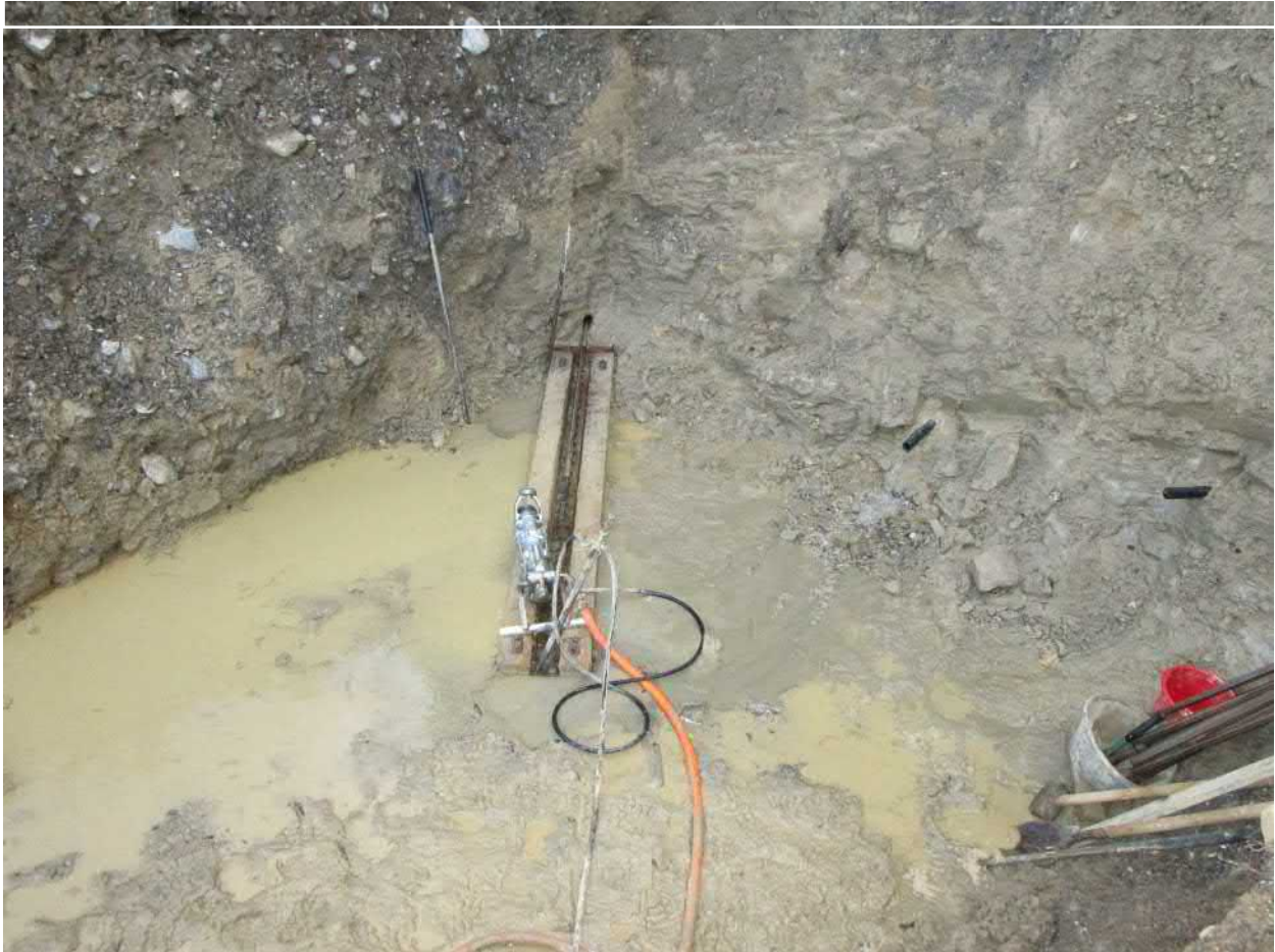
Das Wasser fließt reichlich aus der neu erstellten Horizontalbohrung
